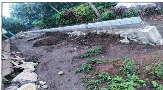
Foto 4: Muro de contención.
