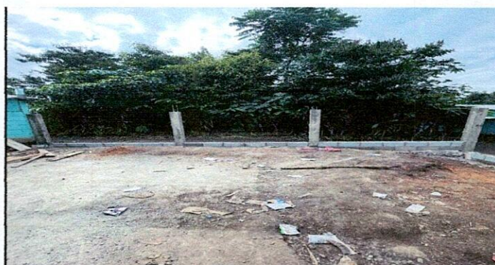
Foto 6: Ampliacion de 8 metros de muro de contención.
