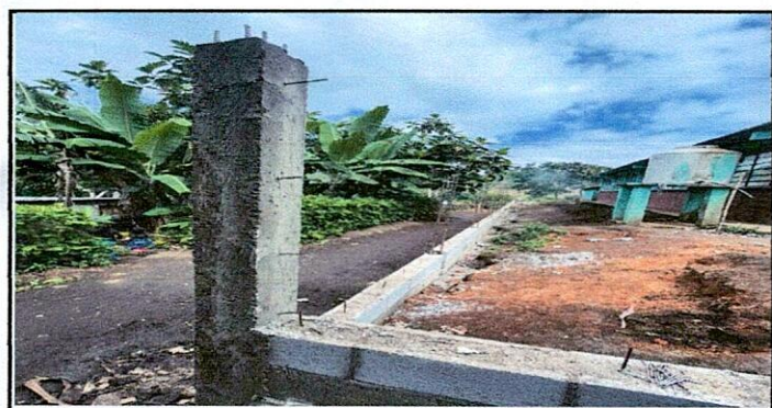
Foto 4: Muro de contención.
