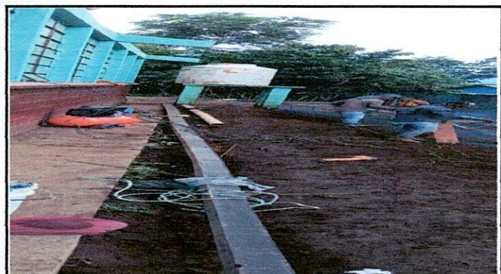
Foto 3: Canales y bajadas de agua pluvial.
