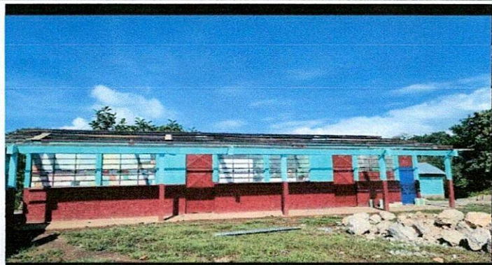
Foto1: Cubierta de lamina.
